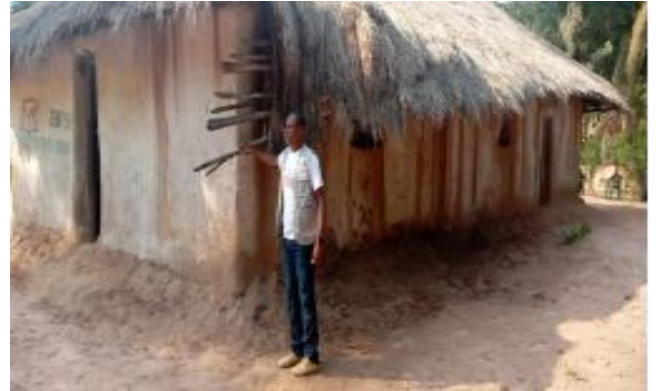
L'Etat de délabrement de la toiture du local de rassemblement, avec l'arrivée de la saison de pluie les murs seront attaqués, d'où la nécessité de couvrir ce bâtiment avec la toiture en tôles.
